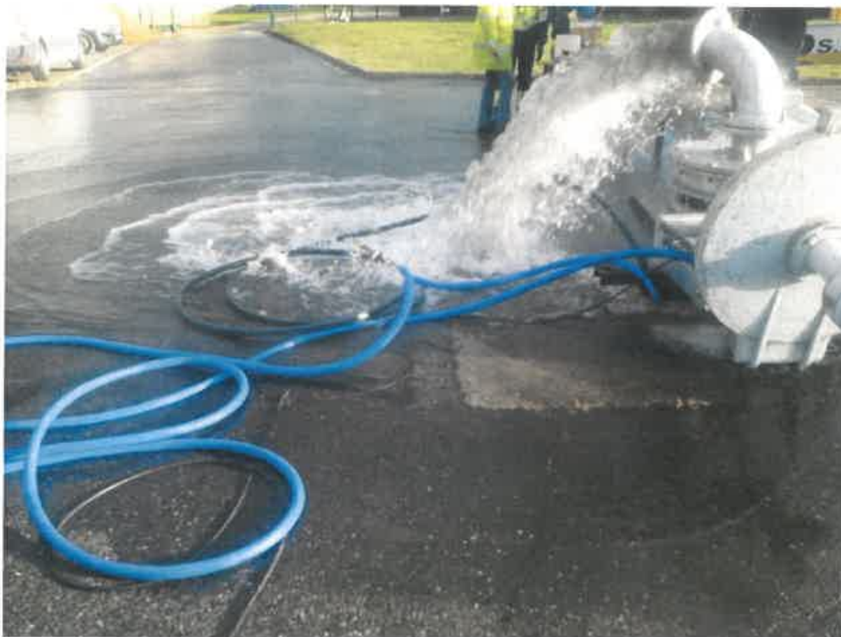
Changement de la pompe du forage à Morhange – Novembre 2015
